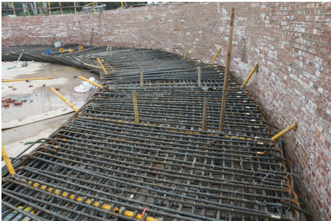
事故现场照片 2
